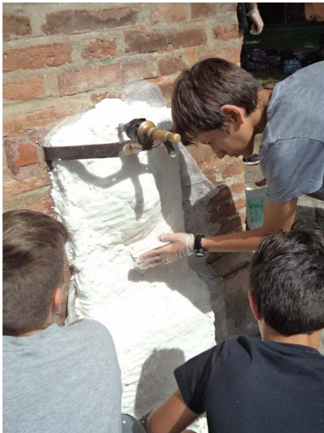
Fig. 14. Applicazione dell'impacco.
