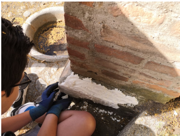
Fig. 10. Rimozione dell'impacco.
