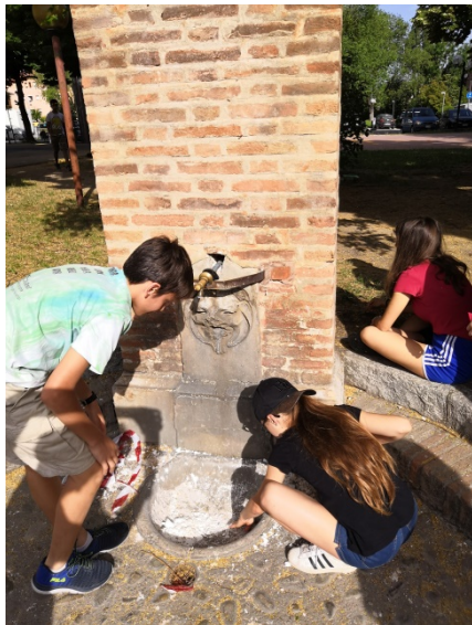
Fig. 25. Pulitura dei resti dell'impacco.
