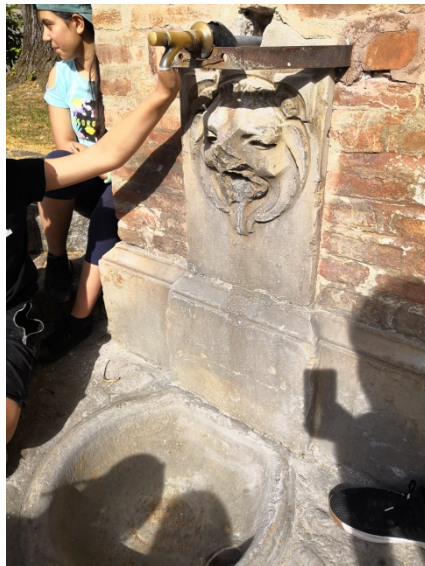
Fig. 26. La fontana dopo la rimozione dell'impacco.
