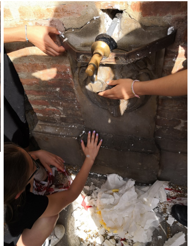
Figg. 23-24. Rimozione dello strato di carta giapponese e l'impacco polpa di cellulosa
