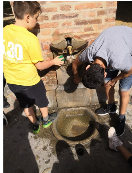
Fig. 27. Pulitura con le spugne e l'acqua distillata.
