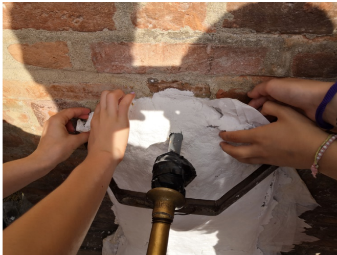
Figg. 23-24. Rimozione dello strato di carta giapponese e l'impacco polpa di cellulosa
